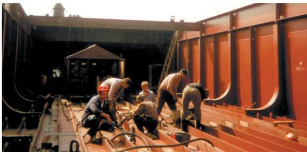
Рис. 1. Процесс сварки на нижнем поясе пролета моста
