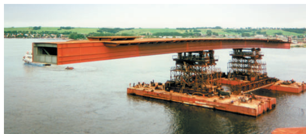
Рис. 4. Буксировка пролета длиной 147 м для установки на опоры моста
