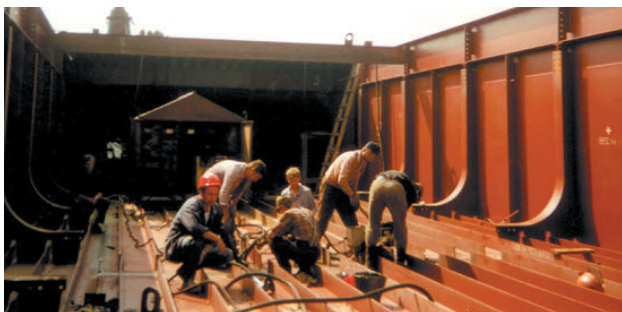
Рис. 1. Процесс сварки на нижнем поясе пролета моста
