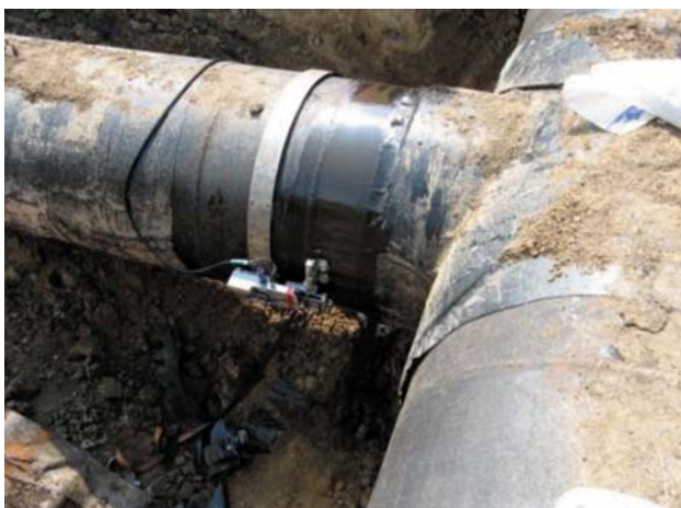
Рис. 16. Автоматизированный голографический контроль сварных соединений тройников с накладками
