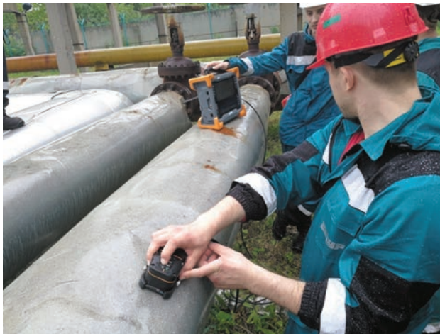
Рис. 10. Полевые испытания РЕС на производстве азотсодержащих продуктов. Объект контроля – трубопровод в изоляции, обшитый листами оцинковки
