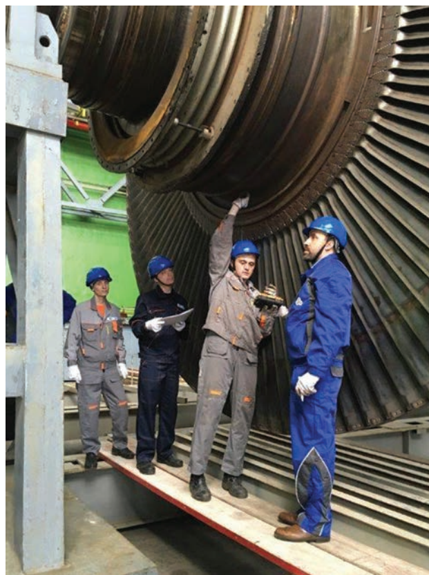
Контроль лопаток турбины АЭС Козлодуй, Болгария
