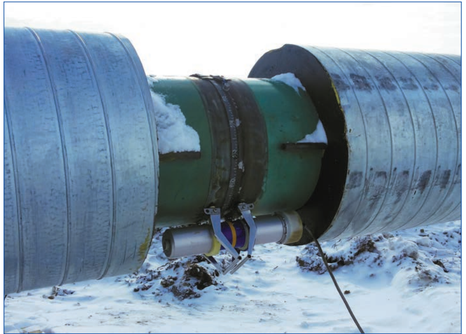
Рентгенография сварного шва трубопровода. Моноблок аппарата 0,3 СБК 160 С закреплен на объекте контроля с помощью патентованного магнитного устройства крепления на трубе
