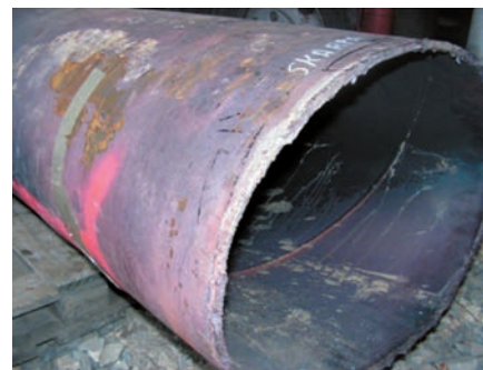
Рис. 1. Разрушение монтажного кольцевого сварного соединения на газопроводе \varnothing 500 мм после 40 лет эксплуатации
