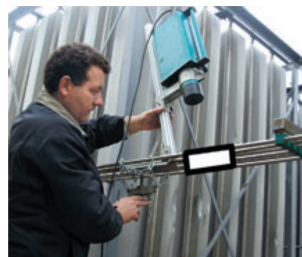
Рис. 2. Размещение РТВ-03 на четырехниточном трубопроводе
