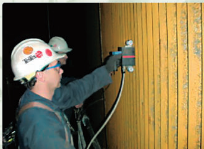
Контроль труб котлов
