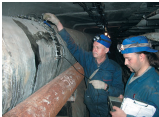
Рис. 1. Контроль бесконтактным магнитометрическим методом теплопроводов через слой изоляции двумя специалистами
