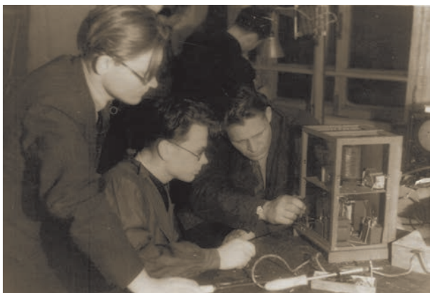
Рис. 9. Инженер С.В. Носиков (справа) и студенты П.С. Клушев (4-й курс) и Л.С. Каверин (5-й курс) за изготовлением ультразвукового дефектоскопа
