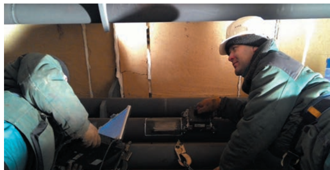
Рис. 21. Обследование труб печей пиролиза
