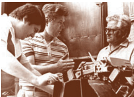
Испытания передвижной лаборатории для УЗ-контроля стыков трубопроводов. А.А. Ткаченко, В.Д. Коряченко, В.Н. Верещагин, 1987 г.
