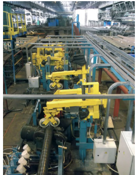
Рис. 3. Комплекс неразрушающего контроля труб
