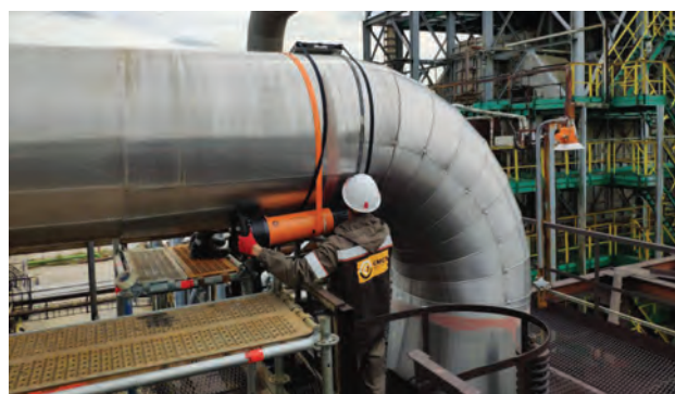
ООО «СМСЛ» – проведение РК на объекте
