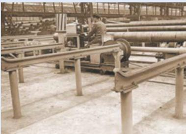
Испытание сварных швов
