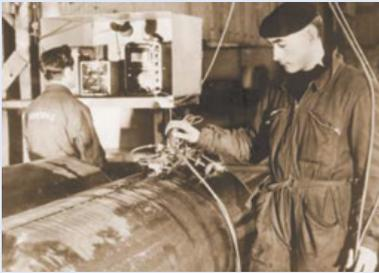
Механизированные испытания сварных швов с использованием USIP
