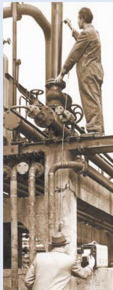
Измерение толщины стенки
