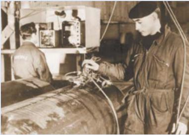
Механизированные испытания сварных швов с использованием USIP
