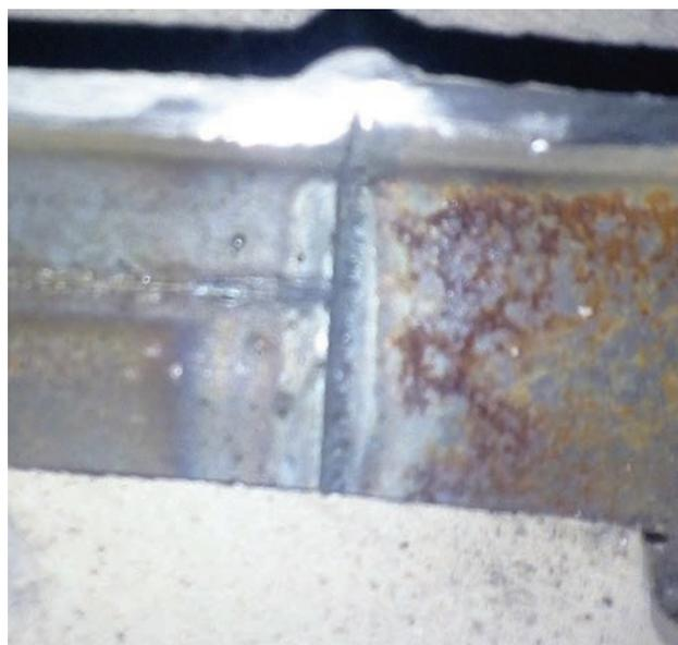
Рис. 2. Непровар фермы промышленного здания
