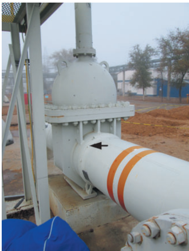
Рис. 3. Узел стыковки нефтепровода \varnothing 700 \times 10 мм с корпусом арматуры
