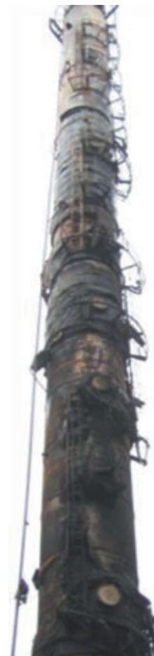
Рис. 2. Колонна после аварии
