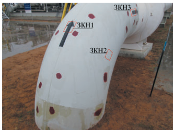
Рис. 1. Изгиб нефтепровода, присоединенный к патрубку арматуры сваркой: ЗКН1, ЗКН2, ЗКН3 – зоны концентрации напряжений, выявленные при контроле методом МПМ; ● – зоны контроля толщины стенки по инструкции
