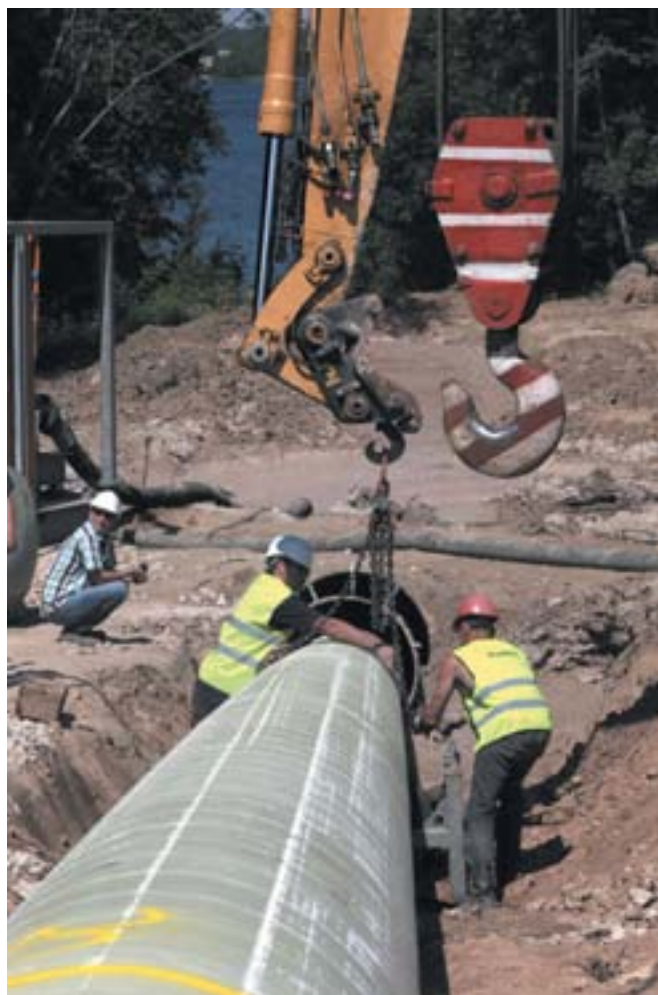
Прокладка магистрального газопровода под Даугавой методом горизонтального бурения
