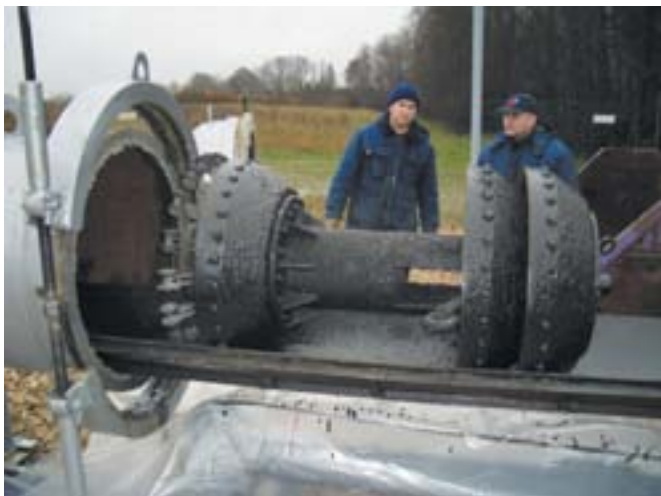
Диагностика магистрального газопровода
