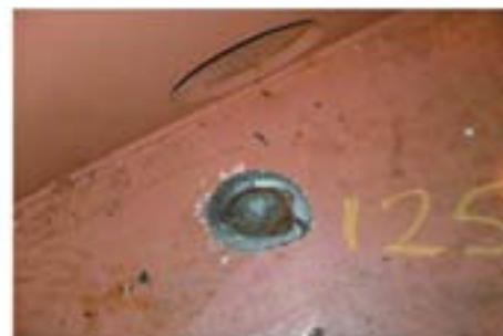
Рис. 1. Металлическое покрытие внутренней поверхности резервуара, которое подлежит оценке на критическое изолированное коррозионное поражение (изображения предоставлены American Bureau of Shipping)
