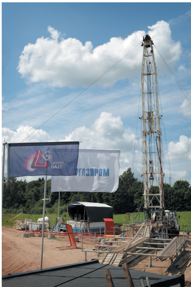
Реконструкция скважины на ПГХ в соответствии с евростандартами
