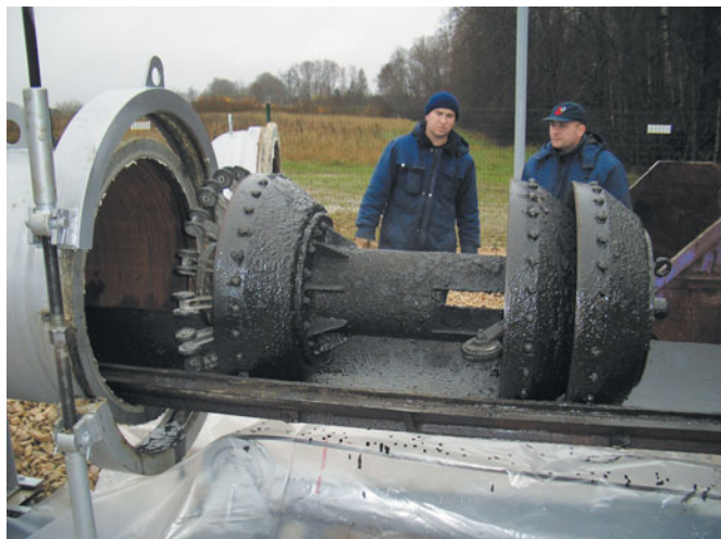
Диагностика магистрального газопровода
