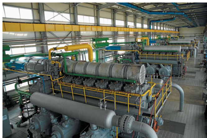
Компрессорный цех ПГХ
